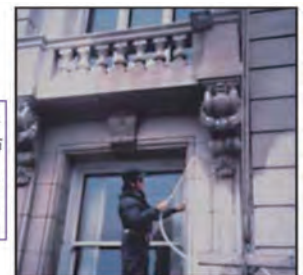
図6. スプレー塗布 大きな構造物をシラン処理するのに適しています。
